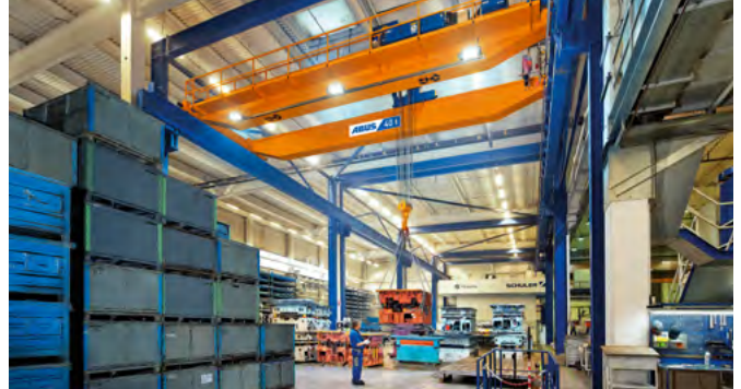
Bestückung mechanischer Bearbeitungsmaschinen
