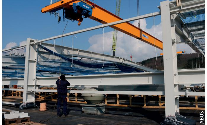
Selten kann ein Laufkran so komfortabel montiert werden. Der Abus-Monteure steht auf dem alten Hallendach und dirigiert den Autokran. Links und rechts sieht man die neuen, längeren Hallenstützen aus dem alten Dach ragen.
