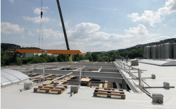
Die Montage eines Einträgerlaufkrans ist eine Sache von wenigen Stunden. Bei kurzem Radstand kann der ELK komplett montiert zur Baustelle gebracht werden und muss dann nur auf die Kranbahn gehoben werden.
