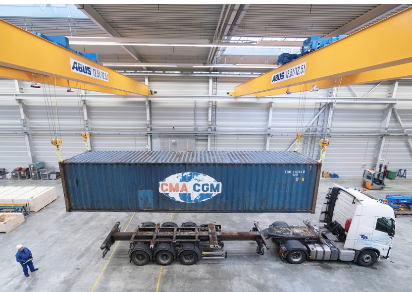
Bis zu zwei Katzen auf zwei Kranen können durch Abucontrol synchronisiert und für gemeinsame Hubaufgaben eingesetzt werden. (Bild: Abus)
